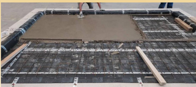
Fotos de montaje de muestra de ensayo
