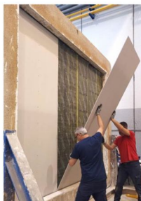
Fotos de montaje del trasdosado
