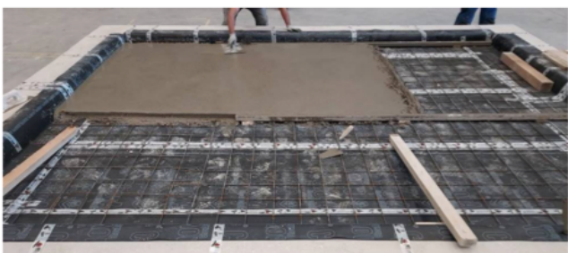
Fotos de montaje de muestra de ensayo
