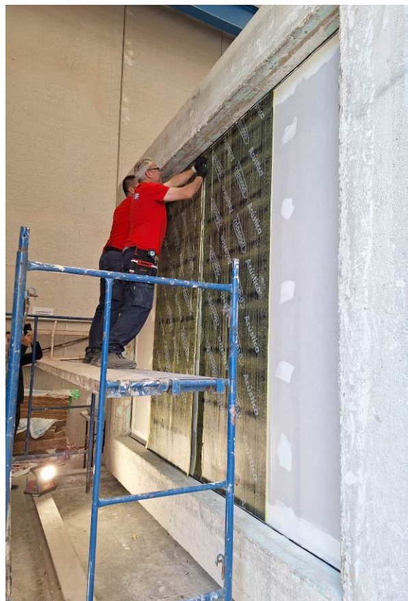
Fotografien von der Montage des Prüfgegenstands
