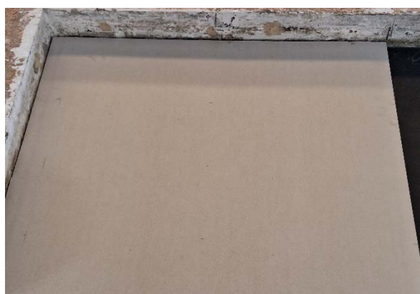
Fotografien von der Montage der Hintermauerung
