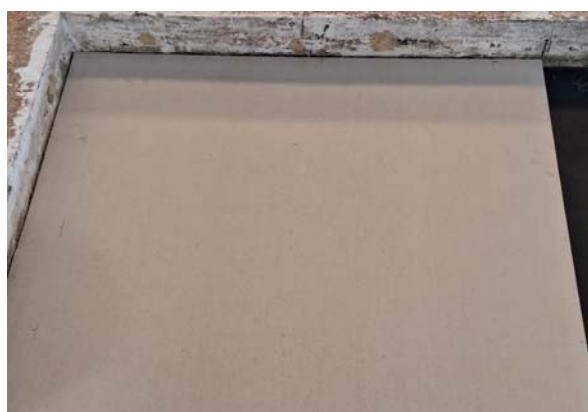
Fotos de montaje de trasdosado
