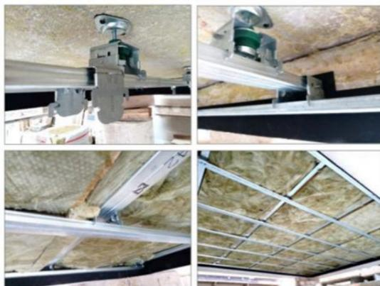
Imágenes 16 a 19 Colocación de la estructura y lana mineral
