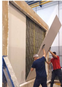
Fotos de montaje del trasdosado
