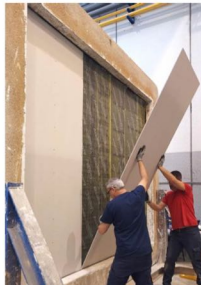
Fotos de montaje del trasdosado
