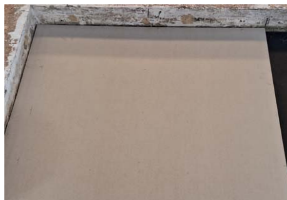
Fotos de montaje de trasdosado
