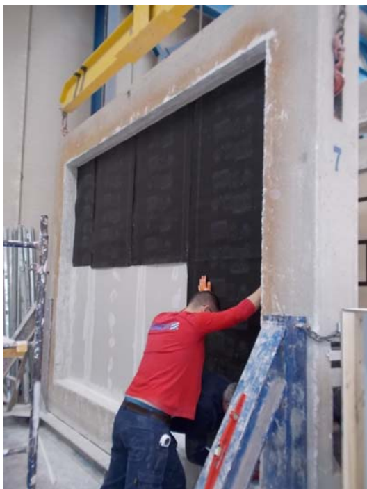
Fotos de montaje del trasdosado
