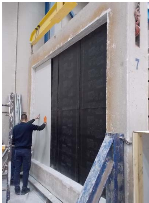
Fotos de montaje del trasdosado
