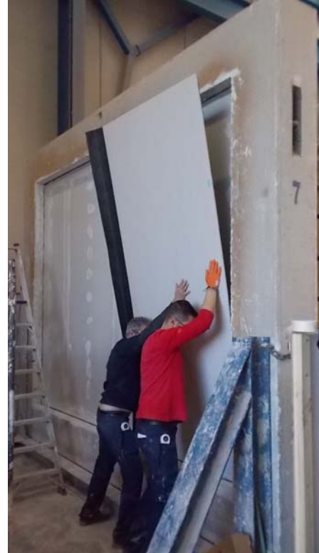
Fotos de montaje del trasdosado
