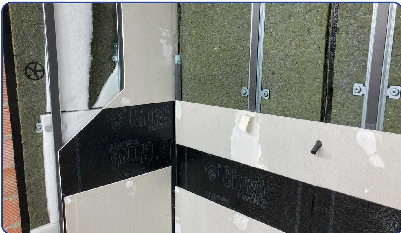
La bande bicouche avec la bande acoustique EPDM et les isolateurs **SEÑOR** obtiennent des excellents résultats d'isolation acoustique.
