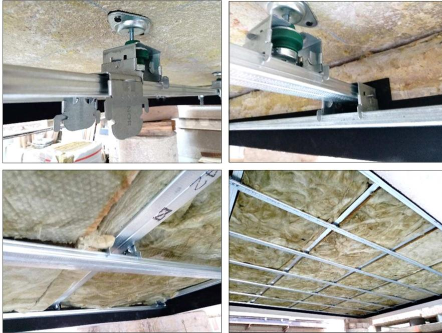
**Imágenes 14 a 17 Colocación de la estructura y lana mineral**
