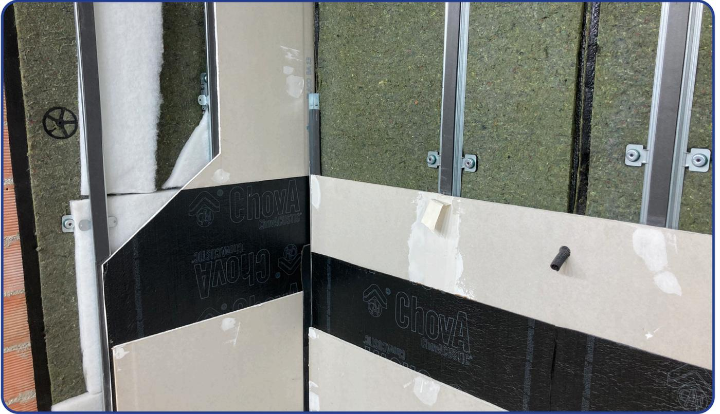
La banda bicapa junto con la utilización de banda acústica EPDM y amortiguadores acústicos **SEÑOR** consigue un aislamiento excelente alcanzando los mejores resultados acústicos.
