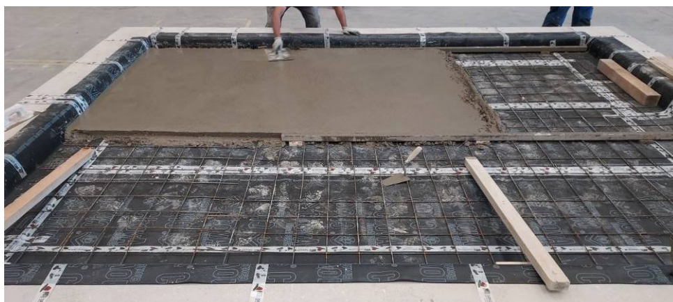
Fotos de montaje de muestra de ensayo
