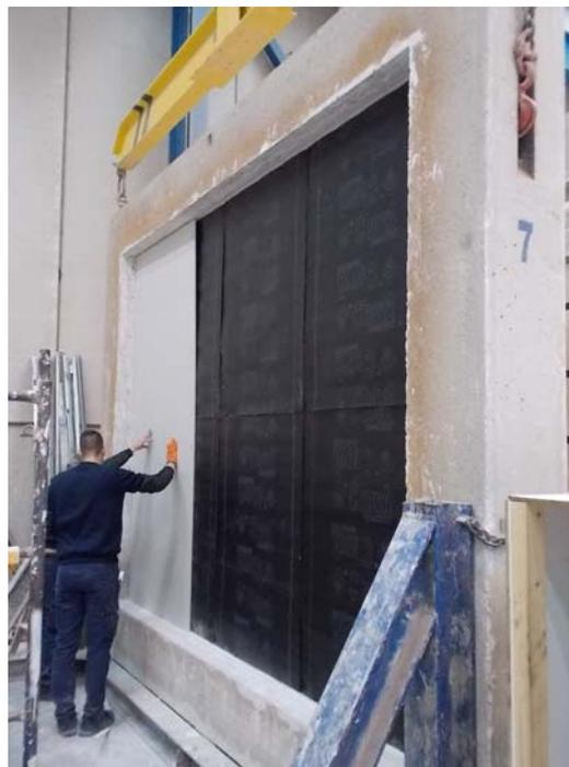
**Photographies du montage de la contre-cloison**
