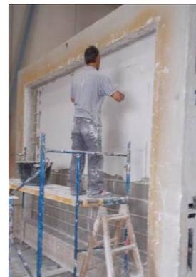
Bloc: 500 mm de largeur x 190 mm de hauteur x 150 mm d'épaisseur et 14,2 kg (masse surfacique estimée: 149 kg/m<sup>2</sup>).
