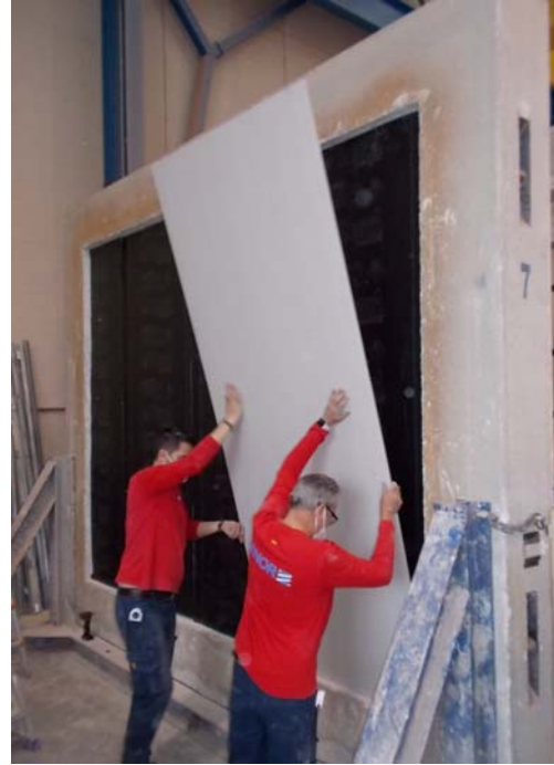
Photographies du montage de la contre-cloison
