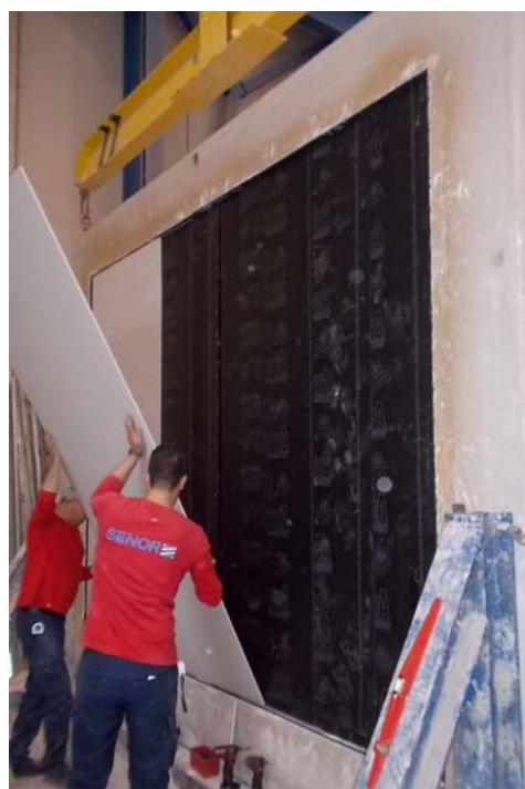
Photographies du montage de la contre-cloison
