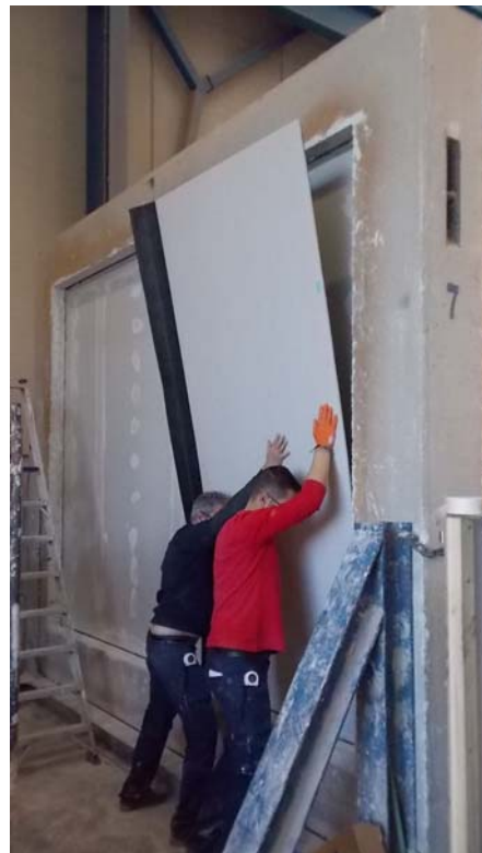
Photographies du montage de la contre-cloison
