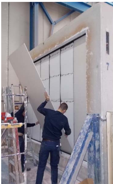
Photographies du montage de la contre-cloison
