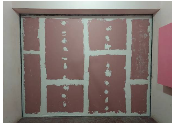
Photographies du la contre-cloison sur mur dans des salles d'essai
