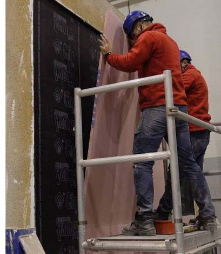
Photographies du montage de la contre-cloison
