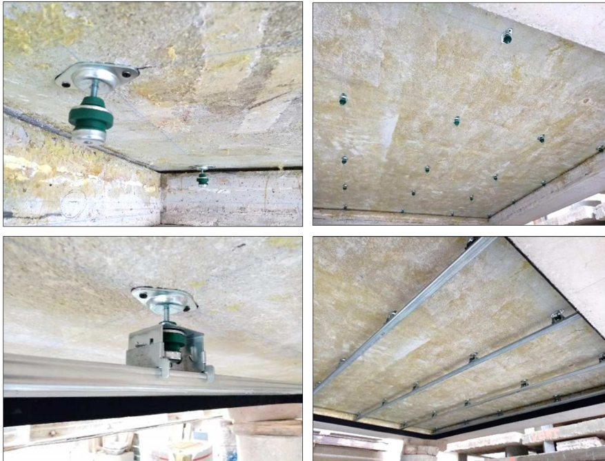
Images 12 à 15 Installation de la ossature
