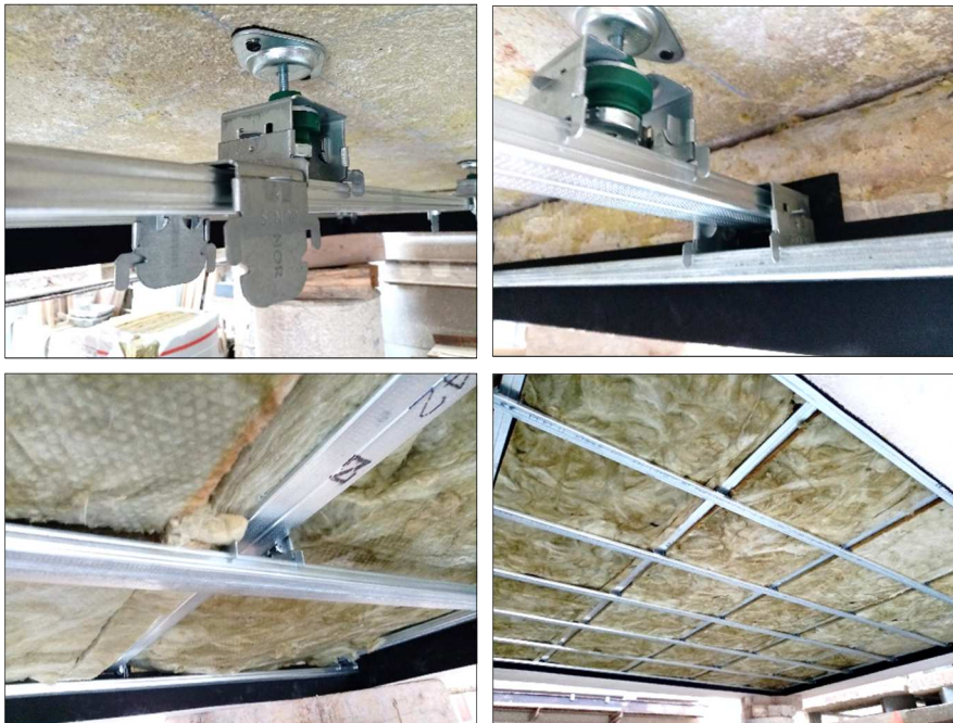
Images 16 à 19 Pose de la ossature et de la laine minérale
