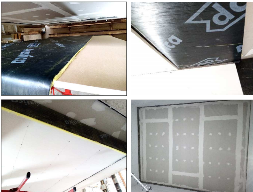
Images 24 à 27 Pose de la film bitumineux et de la 2 e couche de plaque de plâtre cartonnées
