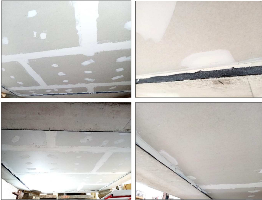
Images 20 à 23 Pose et étanchéité du plaque de plâtre cartonnées
