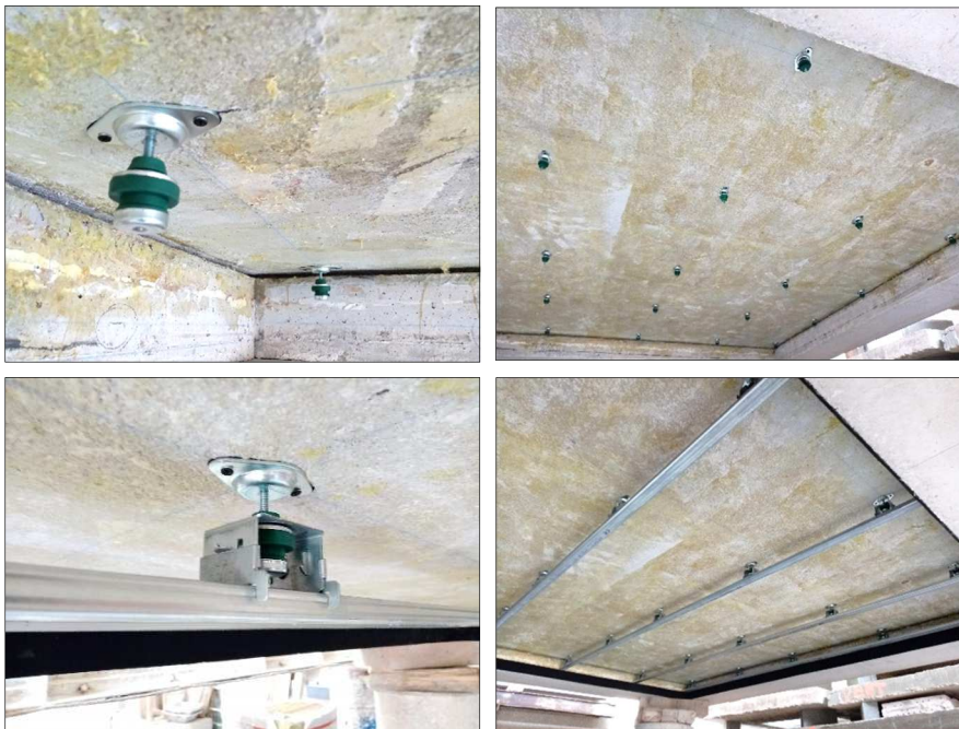
Images 10 à 13 Installation de la ossature
