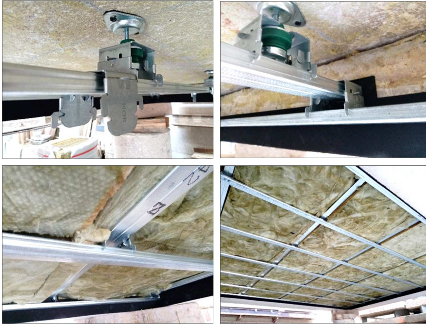
Images 14 à 17 Pose de la ossature et de la laine minérale
