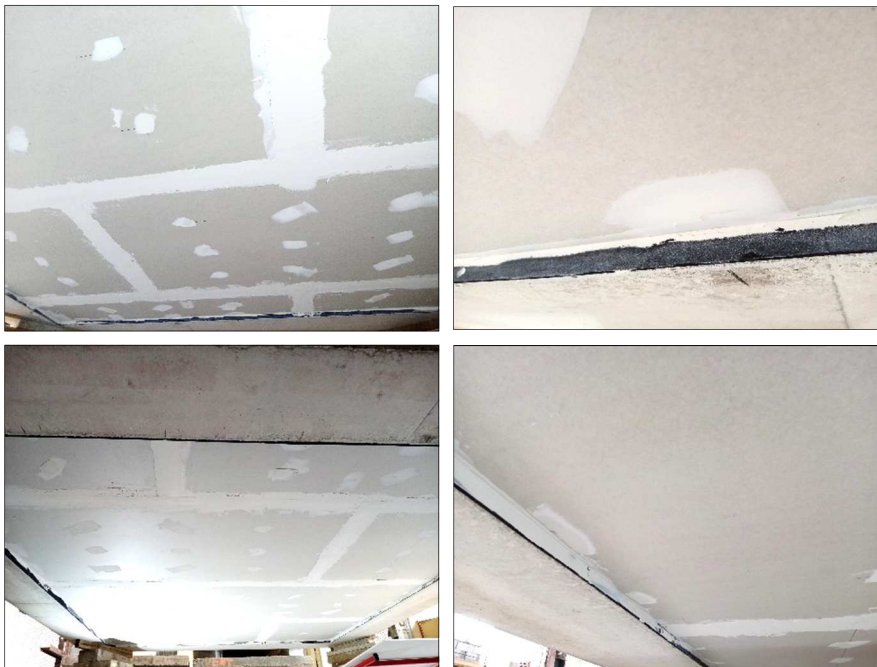
Images 18 à 21 Pose et étanchéité du plaque de plâtre cartonnées
