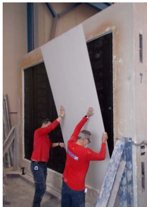
Fotos de montaje del trasdosado
