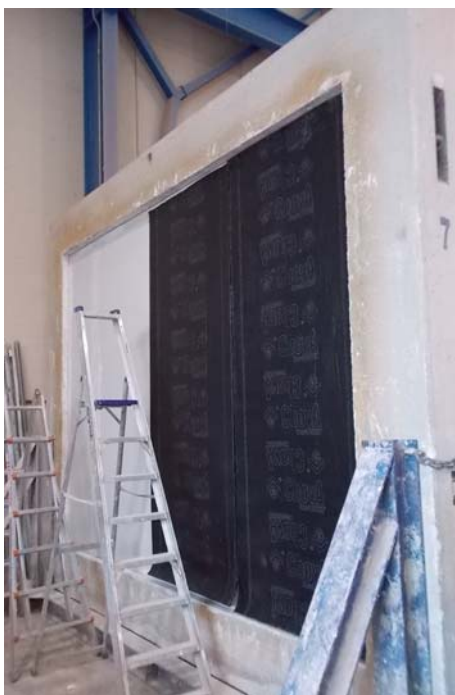
Fotos de montaje del trasdosado
