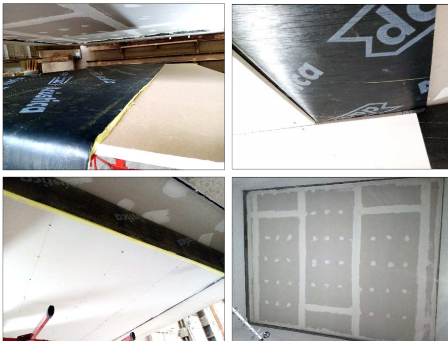
Imágenes 24 a 27 Colocación de lámina bituminosa y 2ª capa PYL
