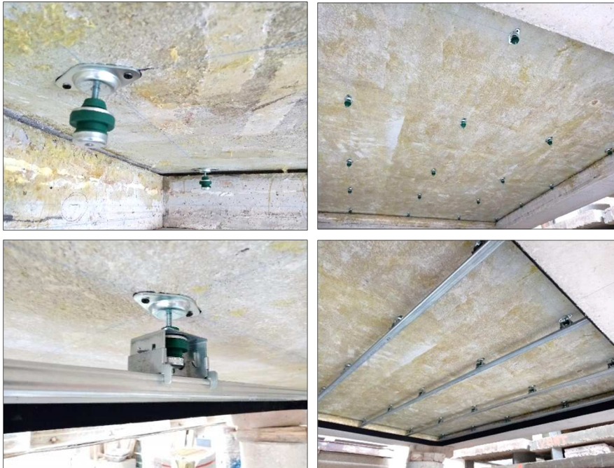
Imágenes 12 a 15 Instalación de la estructura
