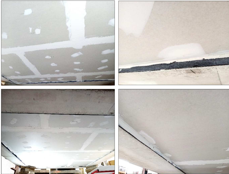
Imágenes 20 a 23 Colocación y sellado 1ª capa PYL
