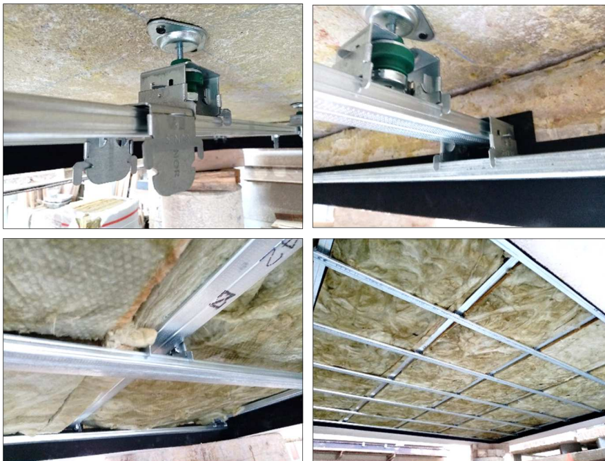
Imágenes 16 a 19 Colocación de la estructura y lana mineral
