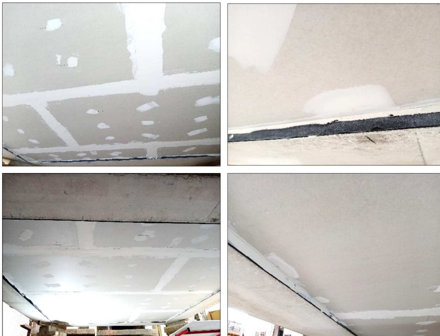
Imágenes 18 a 21 Colocación y sellado PYL
