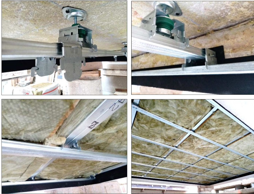
Imágenes 14 a 17 Colocación de la estructura y lana mineral
