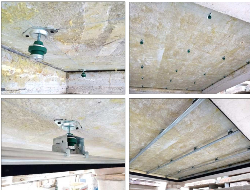
Imágenes 10 a 13 Instalación de la estructura
